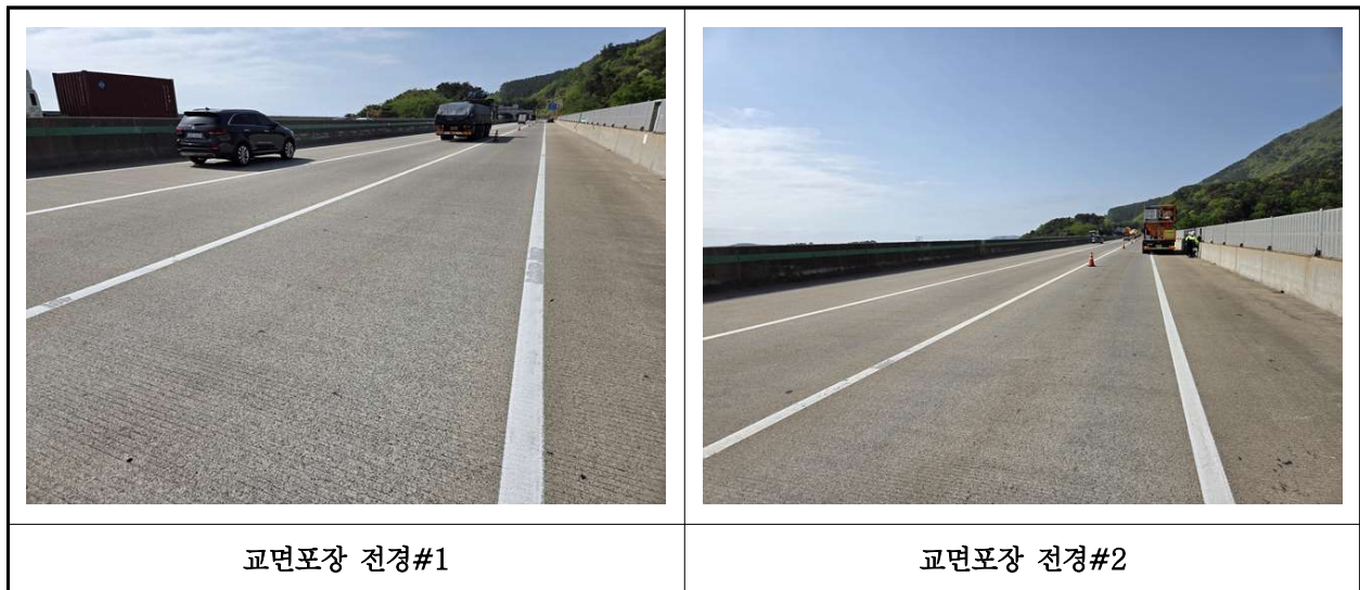
【사진 35.3.20】 교면포장 전경
