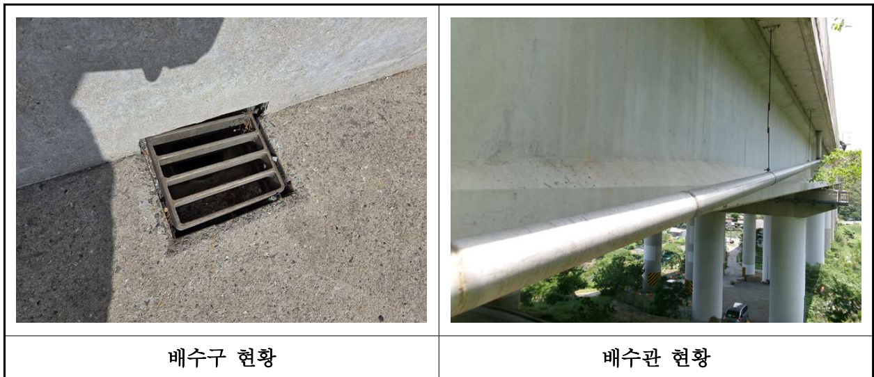
【사진 35.3.22】 배수시설 전경
