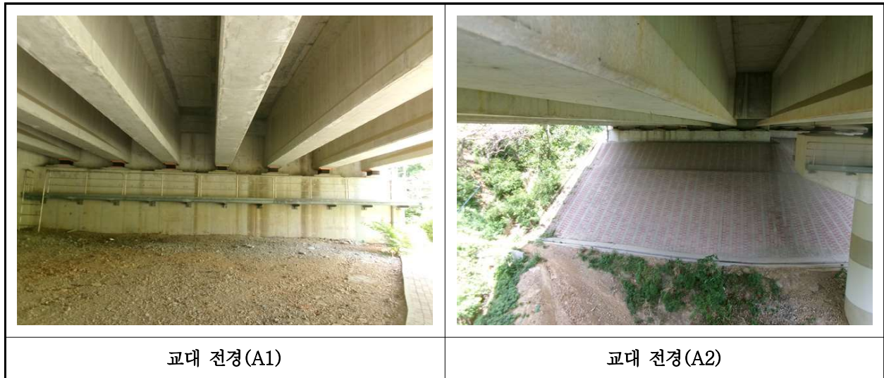
【사진 35.3.8】 교대 전경
