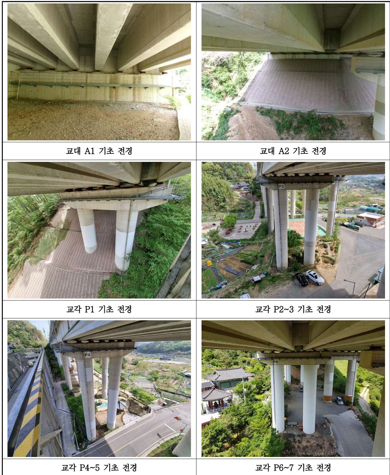
【사진 35.3.12】 기초 전경
