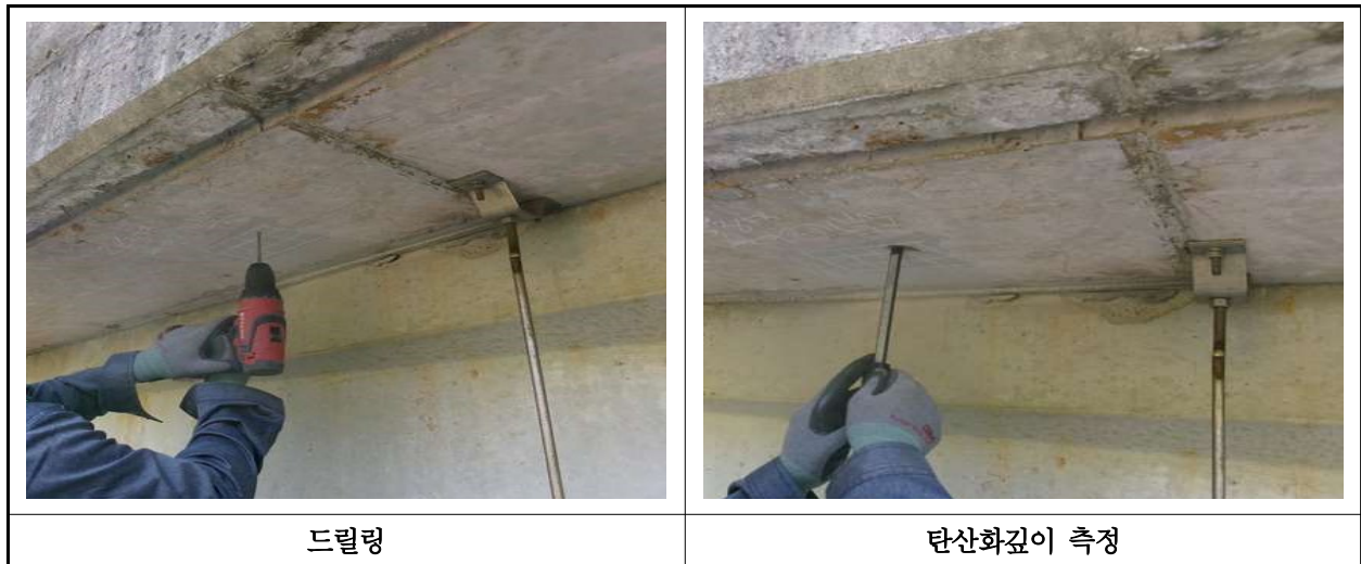
【사진 35.4.3】 탄산화 깊이 측정 현장사진
